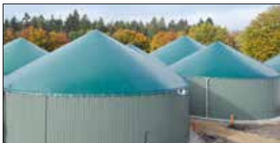
Biogasanlage Gut Hülsenberg
