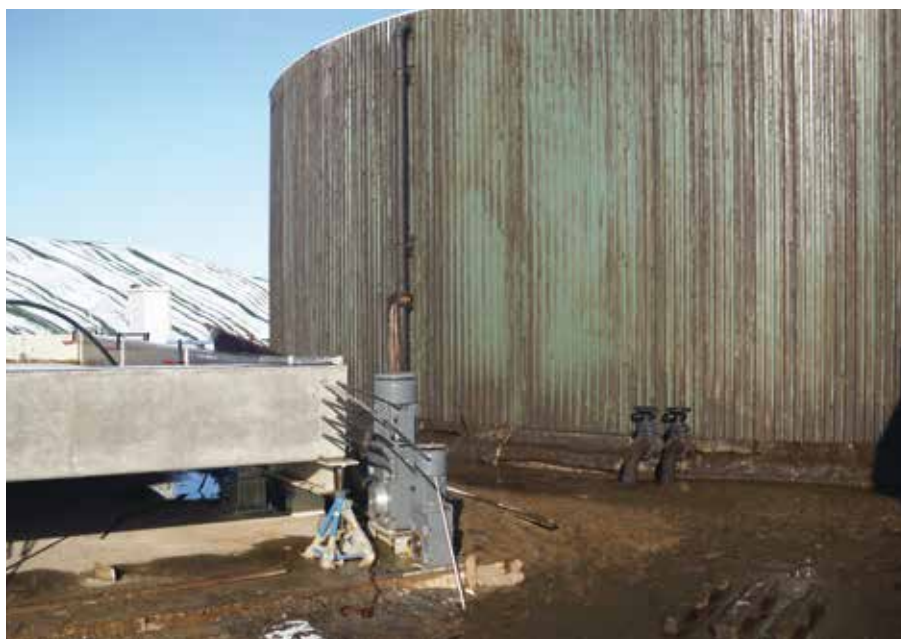
Abb.: Übergelaufener Fermenter nach Aufblähen des Fermenterinhalts („Hefeteigeffekt“)
