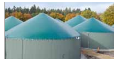
Biogasanlage Gut Hülsenberg
