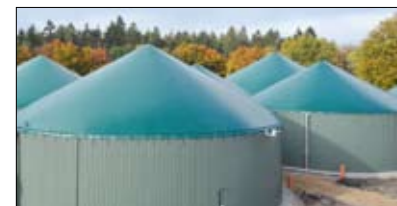
Biogasanlage Gut Hülsenberg
